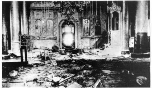
Μια άλλη όψη της αψίδας όπου διακρίνονται και οι καταστραμμένοι πολυκέφαλοι. Another view of the nave with the shattered chandeliers seen.
